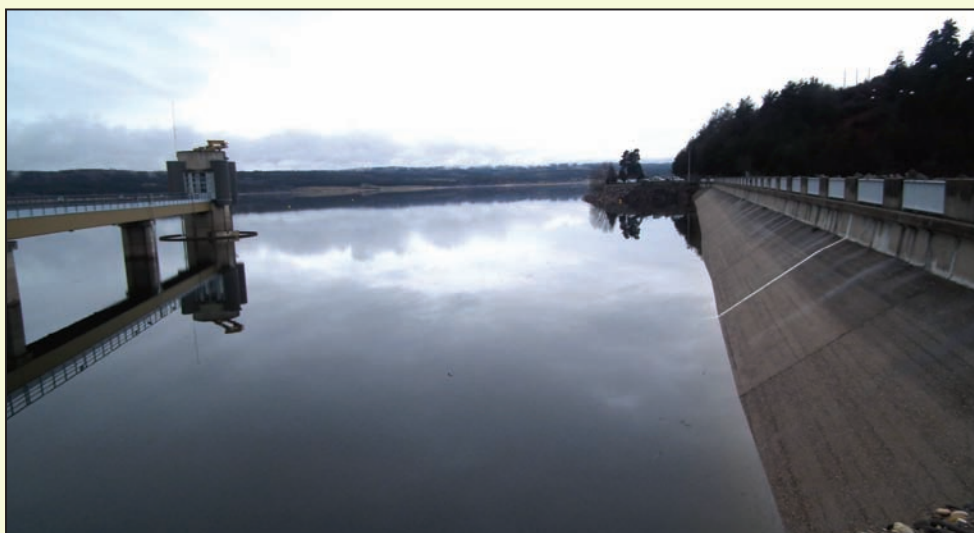
Tour de prise d'eau avec sa voie d'accès. Plaques de béton assurant l'étanchéité
